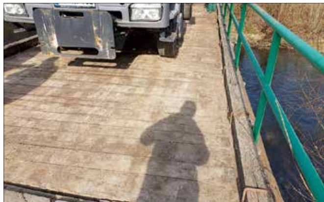
Na mostu v Kokarjah so zamenjali hrastov les z jelovim. (Fotodokumentacija Občine Nazarje)
