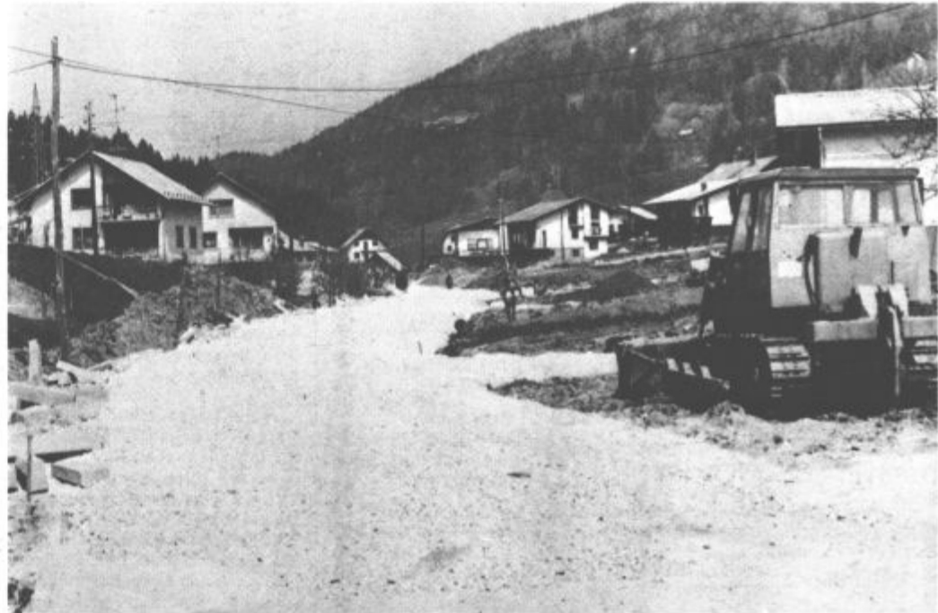
Poleg obsežnih nalog kot je izgradnja gasilskega doma s trgovino in prostori krajevne skupnosti, bodo v letošnjem letu namenili veliko pozornosti tudi razreševanju komunalnih vprašanj. V soseski pod Ljubelo urejujejo kanalizacijo (vos)
