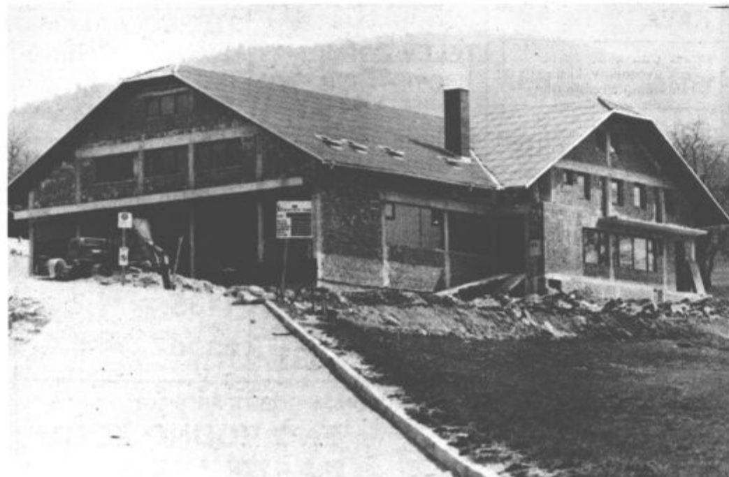
Že čez dva meseca se bo Škalčanom uresničila velika želja. Namenu bodo predali gasilski dom s trgovino in prostori za krajevno skupnost (vos)
