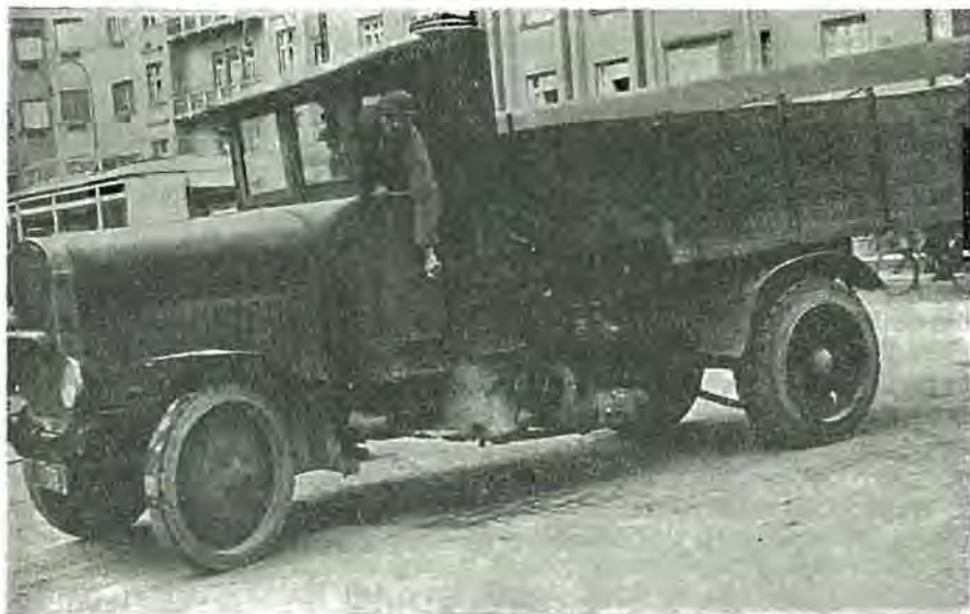
Slika 1. Tovarni avtomobil na pogon z ogljem ali lesom. Generator (G) je montiran ob strani za kabino. (Foto: Mirko Japelj.)
