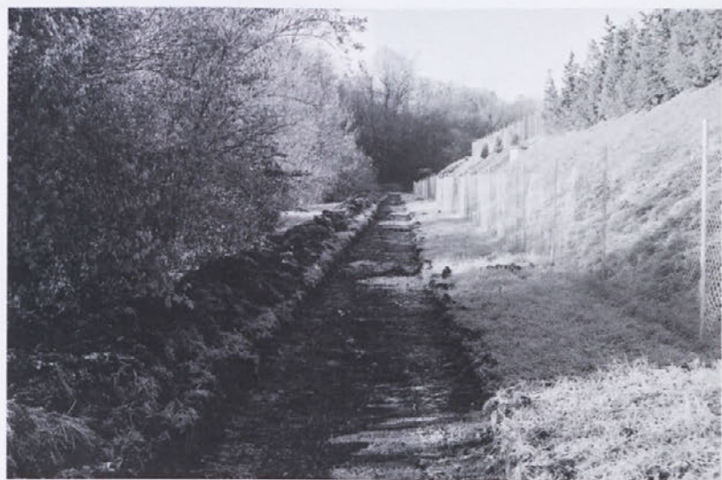
Gradnja Mordaxovega sprehajališča novembra 2004
