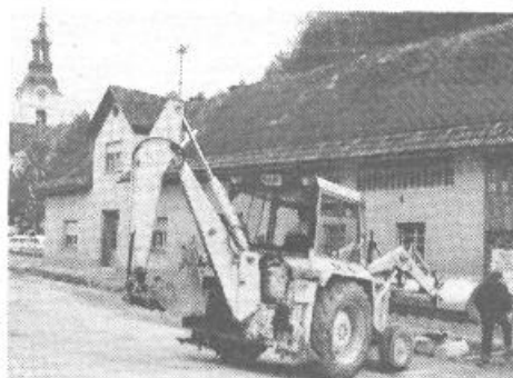
Nadaljevanje gradnje kanalizacije
