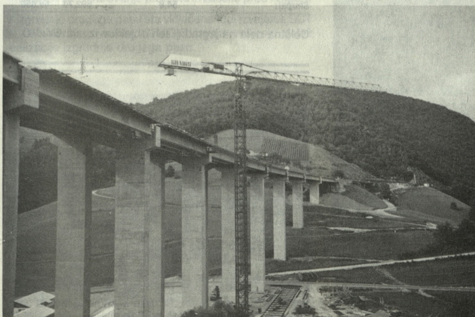
Slika: Izgradnja viadukta Škedenj I. 60-24
