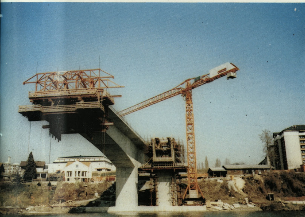
PROSTOKONZOLNA GRADNJA KOROŠKEGA MOSTU V MARIBORU Dela izvaja GRADIS GP Nizke gradnje Maribor
