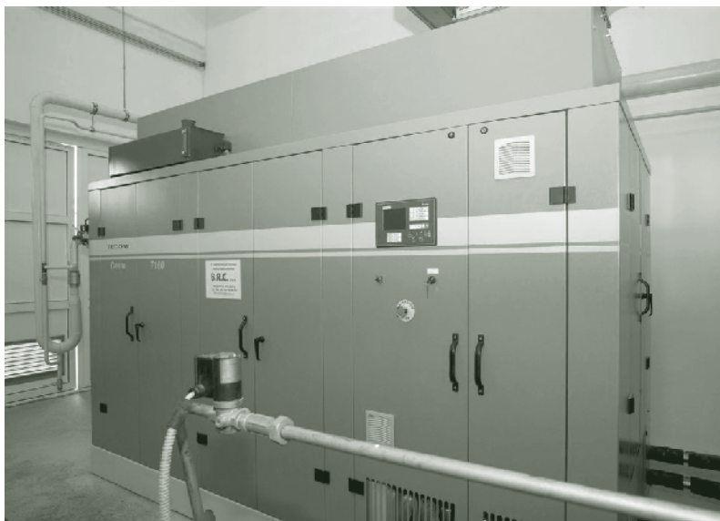
Slika 2. Kogeneracijska naprava moči 150 kW
