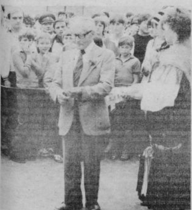
Pred tremi leti so v Draži vasi položili temeljni kamen za dom krajanov in gasilcev, v katerem je našla prostor tudi lepo urejena trgovina Dravinjskega doma. Več kot 4000 delovnih ur so vanj vložili prizadevni krajanji, ki so danes upravičeno ponosni na svojo zmagajo. Na pomoč pa so jim priskočile tudi številne organizacije združenega dela iz občine. Objekt je odprl najstarejši krajan, 90-letni Ivan Štamic.
