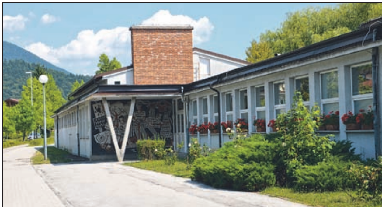
Osnovna šola Miha Pintarja Toleda bo v tem poletju dobila novo kanalizacijo ter elektro-strojne instalacije.
