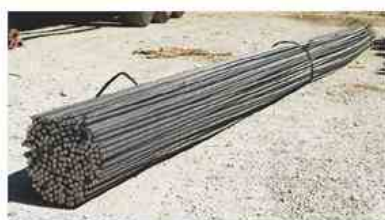
betonsko železo v palicah
