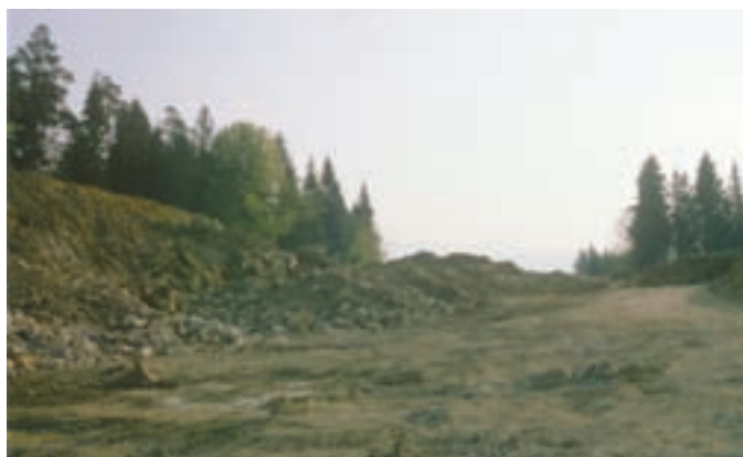
Gradbišče avtoceste na Boštajevem hribu – pogled proti Krtini septembra 2000. Foto: Mirjan Žorž
