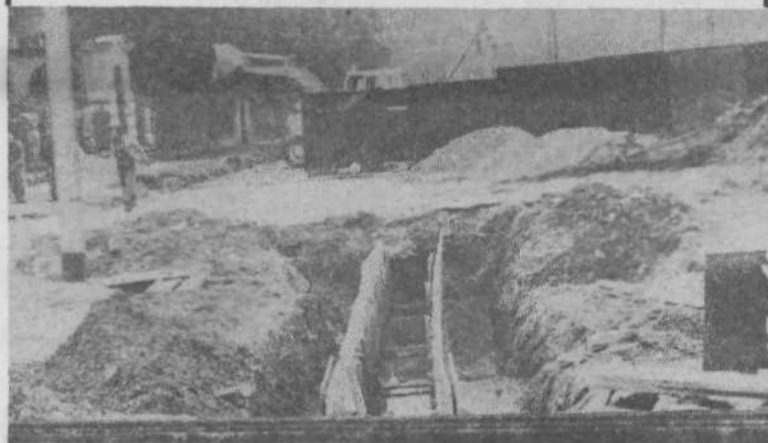
Pri načrtovanju so se glede talne vode opirali predvsem na podatke, ki veljajo pri izgradnji kulturnega doma Ivan Cankar. Čeprav gradbišči nista ravno daleč, je izkop ob začetku del pokazal čisto drugačno situacijo.
