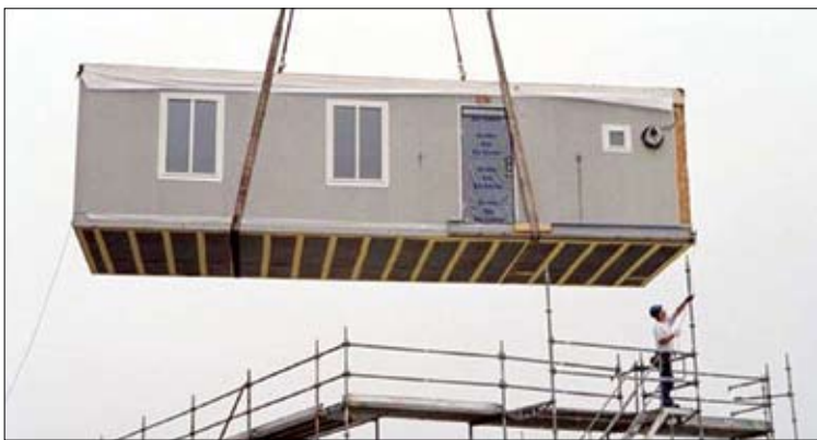
Montažne hiše so sestavljene iz posameznih modulnih elementov, ki so postavljeni na pripravljeno talno ploščo.
