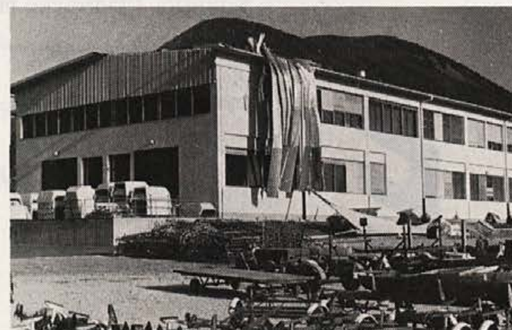
Streha novega obrata plastike je ob navalu vetra vzcvetela
