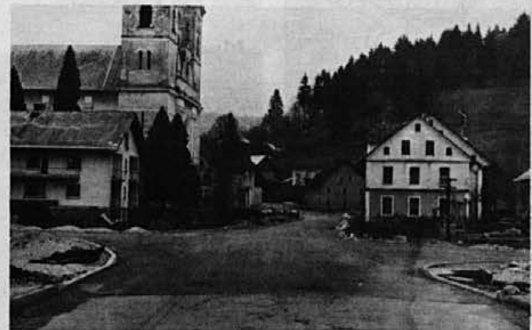
Bodoče križišče glavne ceste z načrtovano obvoznico
