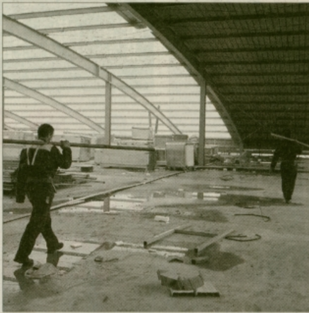
Gradnja novega Vibinega studia v Ljubljani. Foto: Voranc Vogel.
