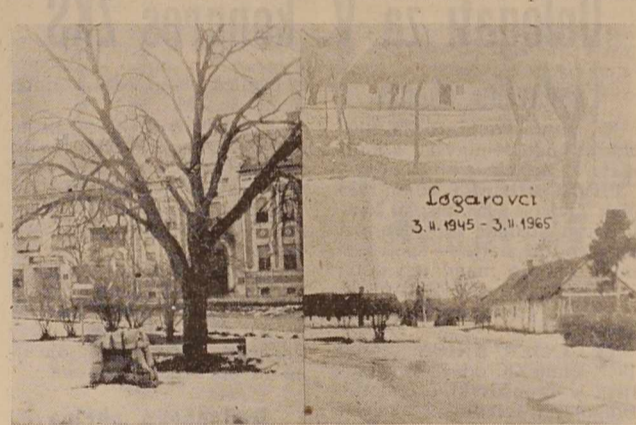
Včeraj je minilo dvajset let od znane bitke med partizani in Kozaki pri Zalikovi domačiji v Logarovcih. Del slike kaže Zalikovo domačijo, na drugem delu pa vidimo tisti del Glavnega trga v Ljutomeru, kjer je okupator po zverinskem mučenju obesil na kostanj Cirila Jureša, borca iz logarovskega spopada. (Foto kino klub Ljutomer).
