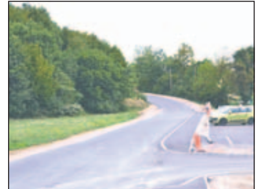
Na tankovski cesti pri izvozu za Star maln so poleg asfaltiranja ceste zgradili parkirišče.
