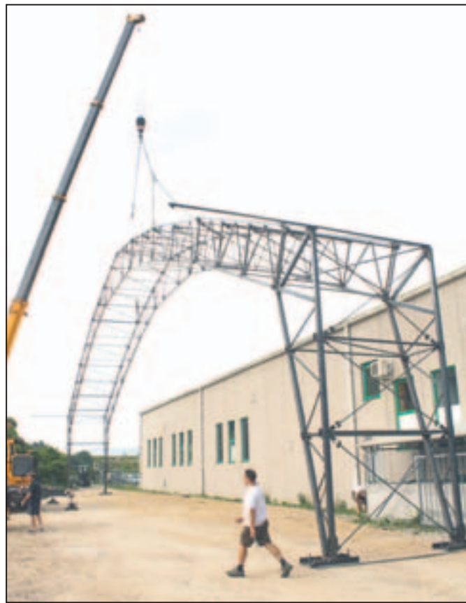
»Poskusna postavitev« konstrukcije za morebitno odkrivanje napak na dvorišču firme
