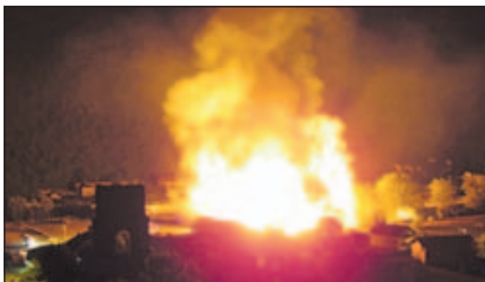
Plameni so segali čez steber viadukta.
