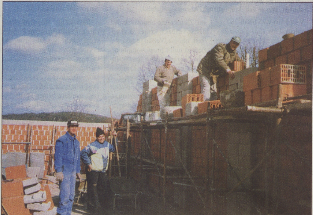
Zidovi Carjevega hleva so se hitro dvigali.
