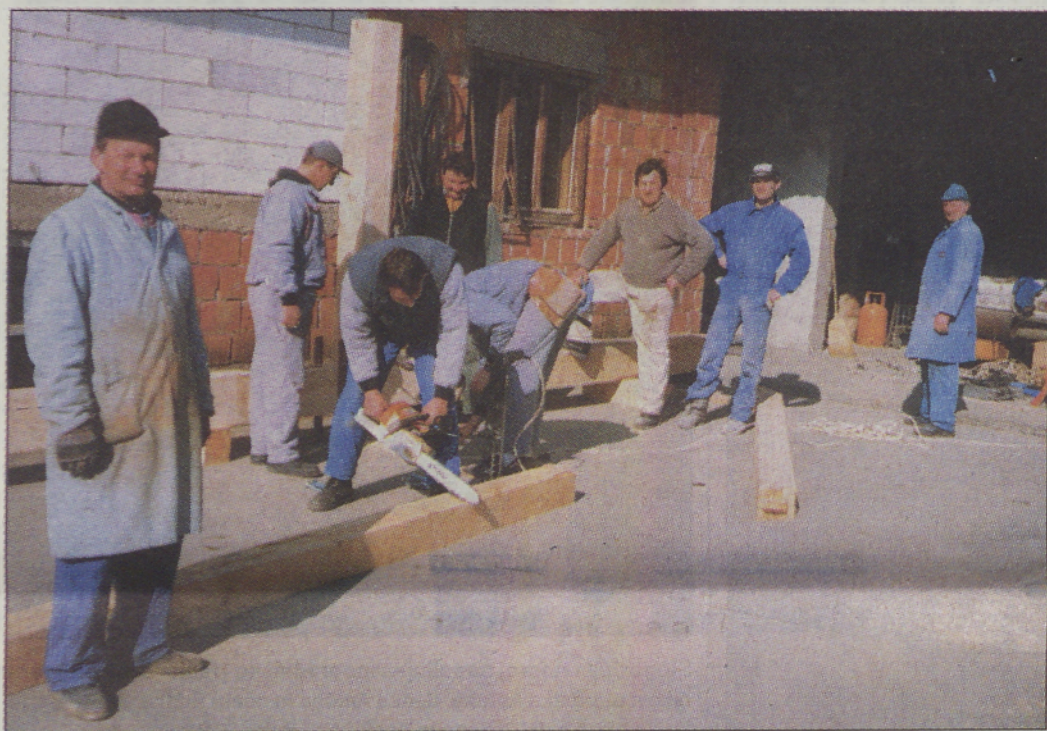
Ostrešje so pripravljali večji tesarji.
