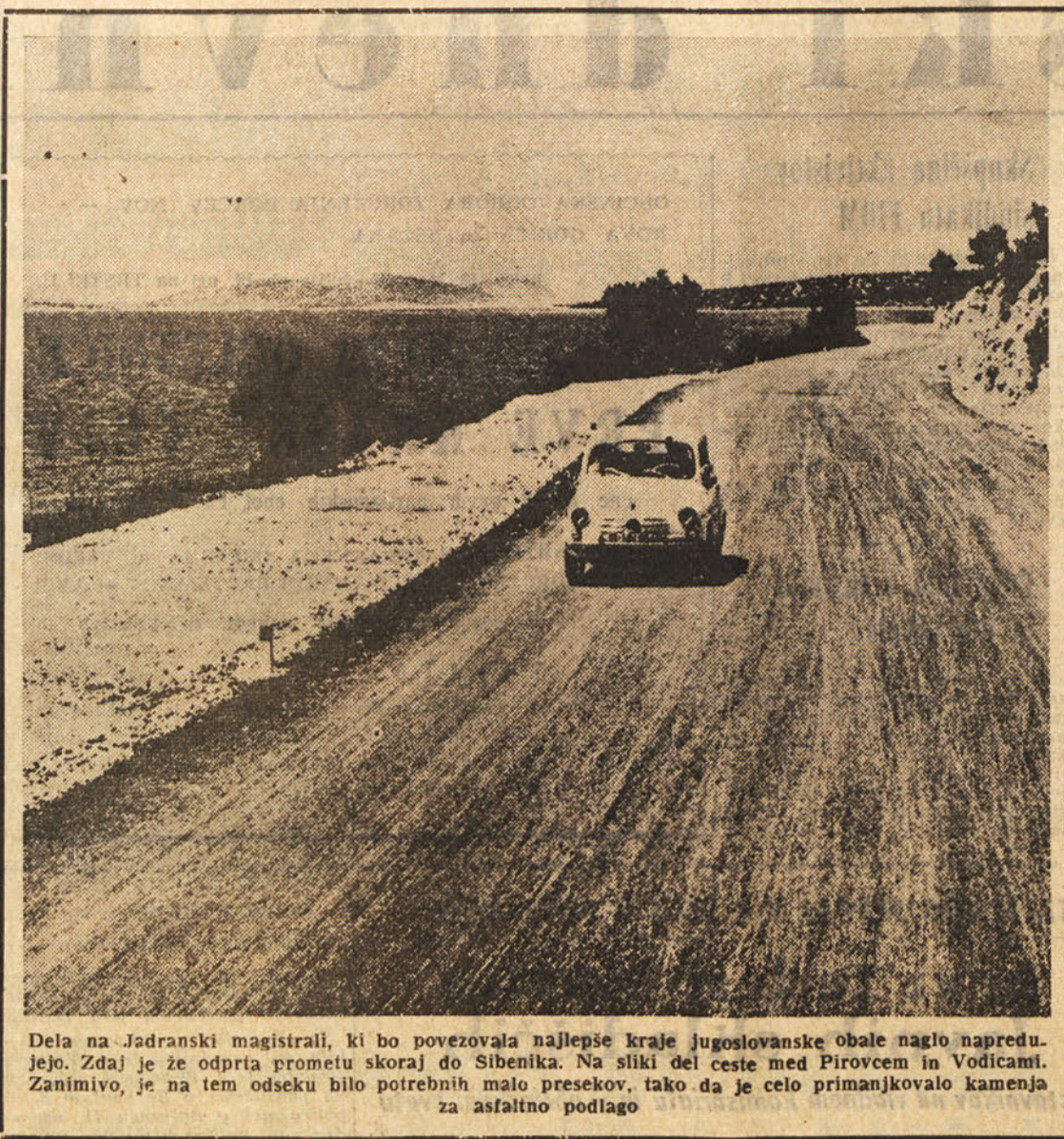
Dela na Jadranskih magistrali, ki bo povezovala najlepše kraje jugoslovanske obale naglo napreduje. Zdej je že odprta prometno skoraj do Sibenika. Na sliki del ceste med Pirovcem in Vodicanmi. Zanimivo, je na tem odseku bilo potrebnih malo presekov, tako da je celo primanjlovala kamena za asfaltno podlago
