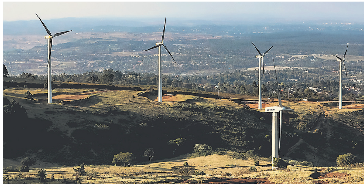
Na Pohorju naj bi več vetrnih elektrarn zgradili po manjših sklopih ter se tako izognili dolgotrajni pripravi obveznega državnega načrta (fotografija je simbolična).
