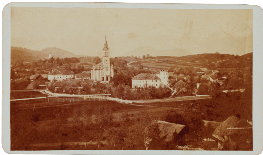
J. R. Weiser: Stara Loka, konec 19. stoletja. (iz fotodokumentacije Grafičnega kabineta NMS)
