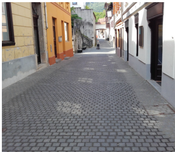
Strojno rezan tlak v Blaževi ulici. Kakšen tlak torej sodi v historično okolje? (foto: Mateja Kavčič)
