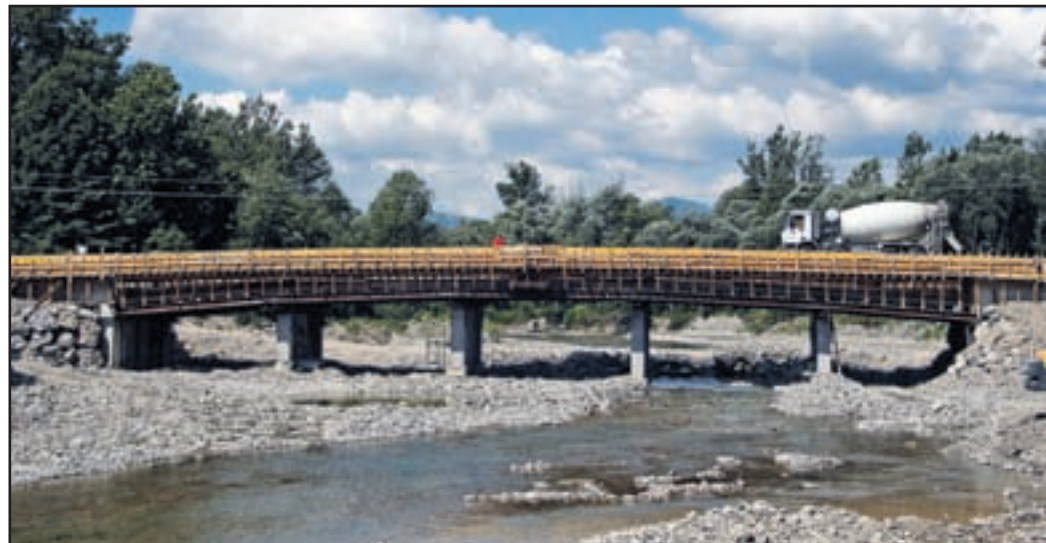
Še zadnji pomembnejši gradbeni podvig je bilo betoniranje veznih hodnikov na vsaki vzdolžni strani mostu. (Foto: Jože Miklavc)
