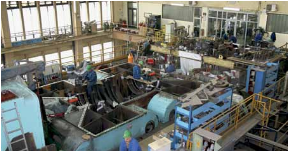
Sklepna dela na ohišju turbine.
