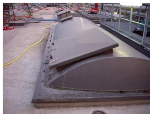
Slika 41: Zaprti bazeni za aeracijo tekočega digestata
