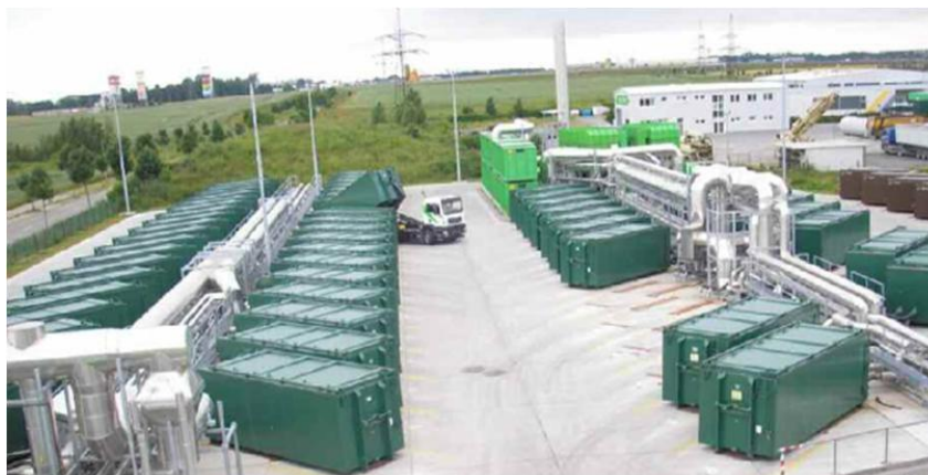
Slika : Bio-sušenje v kontejnerjih in biofilter v ozadju (Breuer, 2007)
