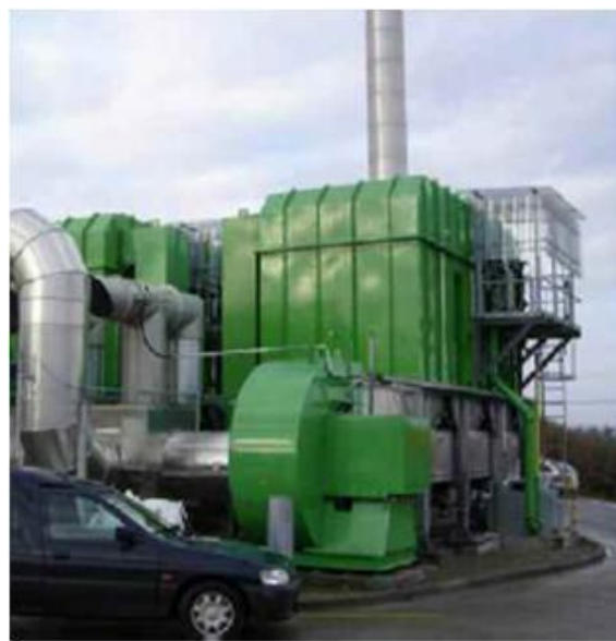
Slika: RTO naprava (Breuer, 2007)
