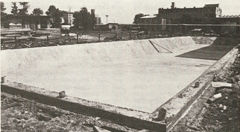
V KTM Protektor te dni končujejo rekonstrukcijo bazena, ki ima zmogljivost 900 kub. m. Rekonstrukcija je stala okrog 70 milijonov starih din. Bazen je pomemben za krajevno skupnost Zelena jama za potrebe civilne zaščite, sprošnega ljudskega odpora, protipožarne varnosti, v KTM pa za hlajenje aluminijevega sulfata ter za morebitne potrebe avtopralnice.
