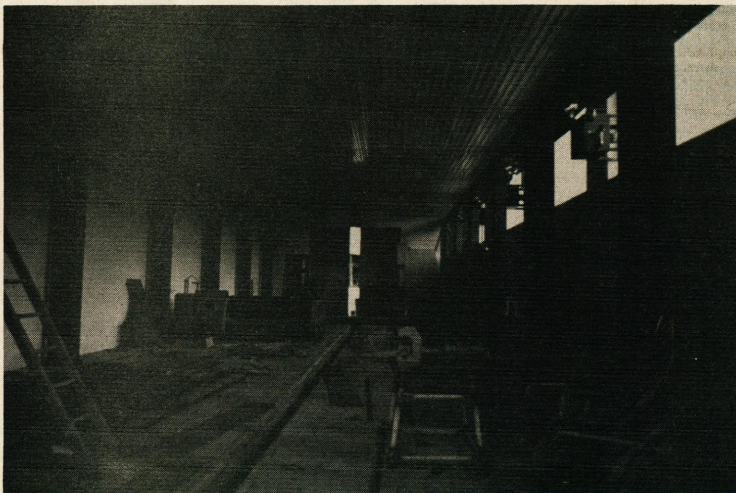
Z odpiranjem novih proizvodnih obratov po krajevnih skupnostih bomo nadaljevali tudi v bodoče, saj s tem krepimo gospodarsko moč občine, občani v odročnejših krajih pa najdejo zaposlitev blizu doma. Na sliki, obrat Kovinarske na Dolah, ko smo še pripravljali proizvodno halo. Danes je iz tega obrata nastala že TOZD.
