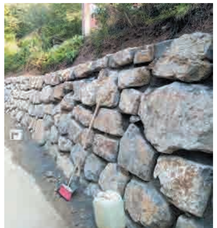
Teren nad cesto so utrdili s kamnito zložbo.
