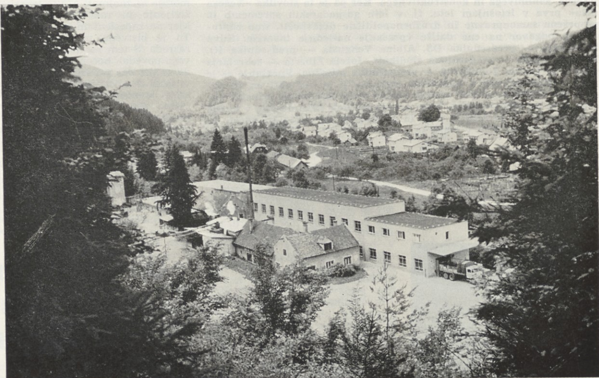
Tovarna dokumentnega in kartnega papirja Radeče pri Zidanem mostu
