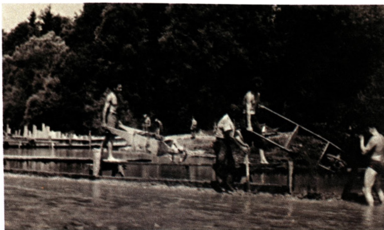
Gradnja vodovoda čez reko Soro, 1956
