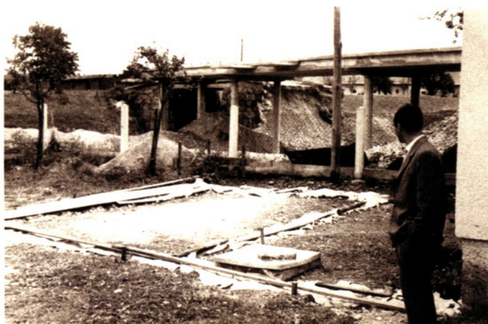
Gradnja mostu čez železniško progo na Zg. Senici, 1960 - 1963
