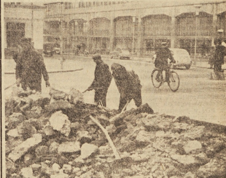
Mar v Ljubljani spet podirajo hiše? Ne. Delavci pripravljajo križišča za ureditev semaforov. Tako bodo kmalu vsa važnejša križišča v Ljubljani opremljena s sodobnimi prometnimi napravami.
