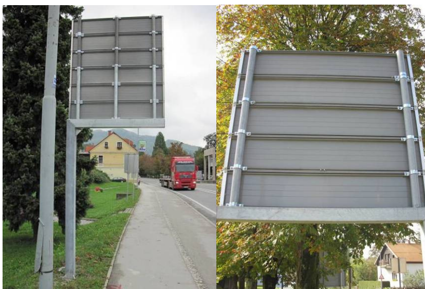
Slika 17: Lamelni sistem je zasnovan tako, da je omogočeno hitro prilagajanje spremembam potreb po vodenih ciljih
