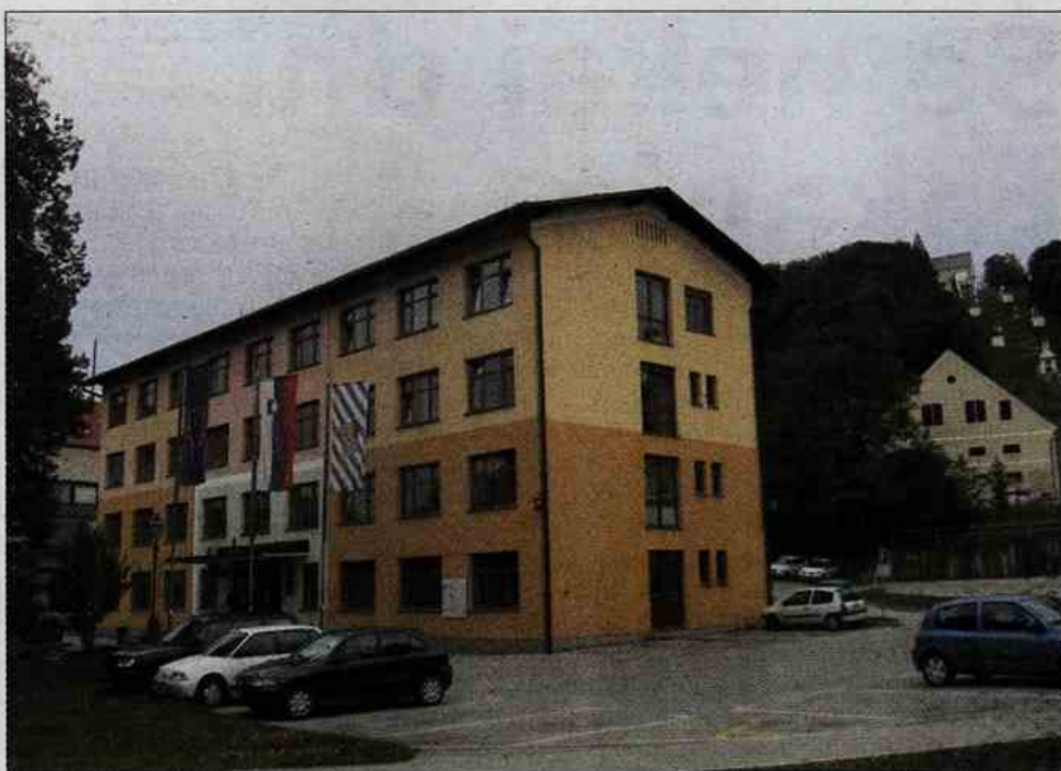
Šokantna ugotovitev, ki povzroča Šmarčanom sive lase. Na videz brezhibna, vendar v resnici statično problematična občinsko-upravna stavba v Šmarju pri Jelšah, ki jo bodo morali po vsej verjetnosti podreti.
