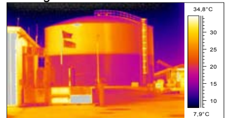
Termogram rezervoarja s tekočino
