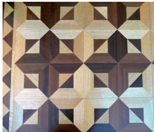
Slika 4: Zanimiv parket - kombinacija termično modificiranega in nemedificiranega lesa (foto: M. Humar)
