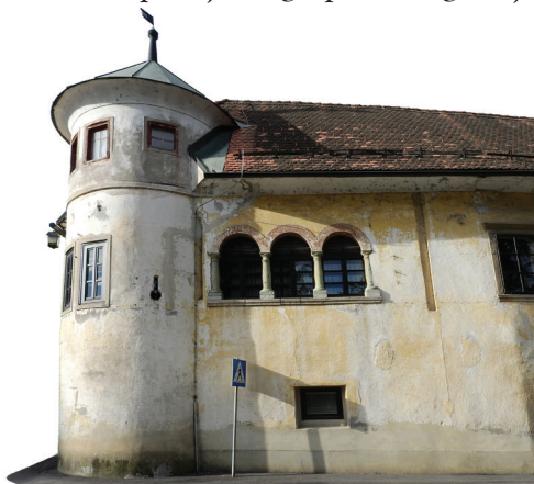
Srednjeveška ključasta strelna lina na okroglem stolpu nakazuje takratno višino obrambnega zidu. (foto: Tomaž Križnar)
