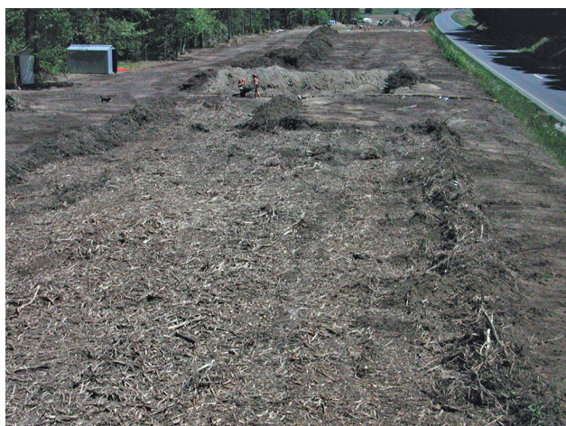
32 Izkopno polje po strojnem čiščenju in delni odstranitvi humusa.
