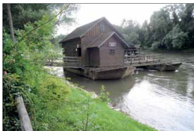
Mlin na Muri sedi na čolnih, reka pa vrti široko vodno kolo. Vir: B. Juvanec ARHITEKTURA SLOVENIJE 2, Severovzhod, i2 Ljubljana 2010.
