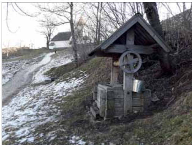
Klasični vodnjak s telesom, leseno streho in vretenom je v Sloveniji najpogostejša arhitektura vode (Sv. Peter nad Begunjami 2017). Foto: Borut Juvanec.
