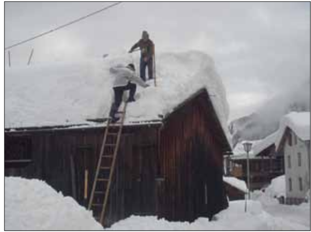
V italijanskih Dolomiti imajo razmeroma položne strehe, da izrabijo sneg za toplotno izolacijo. Ko pa ga je preveč, ga je treba s streh spraviti ročno. To je težko, zamudno in nevarno delo (Dolomiti 2009). Foto: Borut Juvanec.
