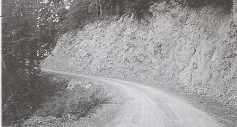
Dobro utrjeno in v hrib zagrizeno cestišče bo letos dobilo asfalt.
