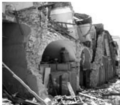
Slika 3 • Zunanjska porušitev zidov zaradi a) slabe povezanosti konstrukcijskih elementov ( http://db.nzsee.org.nz/Seminars/2014/Lagomarsino_Wellington_2014-2-20.pdf ) in b) slabe povezanosti zidov (Silva et al., 2014), L'Aquila, Abruzzo, Italija, c) porušitev stropa bazilike sv. Frančiška Asiškega v Assisiju med potresom v regiji Umbria-Marche leta 1997 ( http://projecthistoryitalia.altervista.org/26-settembre-1997-terremoto-nelle-marche-e-in-umbria/ )
