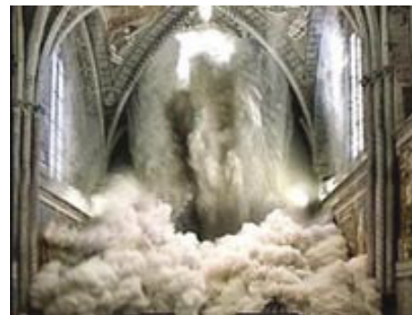
Slika 3 • Zunanjska porušitev zidov zaradi a) slabe povezanosti konstrukcijskih elementov ( http://db.nzsee.org.nz/Seminars/2014/Lagomarsino_Wellington_2014-2-20.pdf ) in b) slabe povezanosti zidov (Silva et al., 2014), L'Aquila, Abruzzo, Italija, c) porušitev stropa bazilike sv. Frančiška Asiškega v Assisiju med potresom v regiji Umbria-Marche leta 1997 ( http://projecthistoryitalia.altervista.org/26-settembre-1997-terremoto-nelle-marche-e-in-umbria/ )
