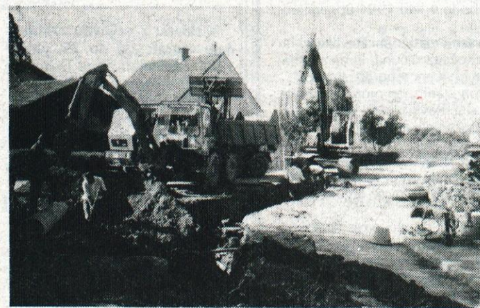
Gradnja kanalizacije v Južnih Domžalah
