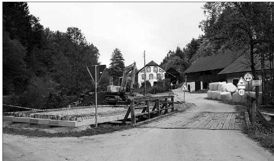
Razen mostu bodo v Ljubiji naredili tudi novo cestišče, ki bo izboljšalo prometno varnost.
