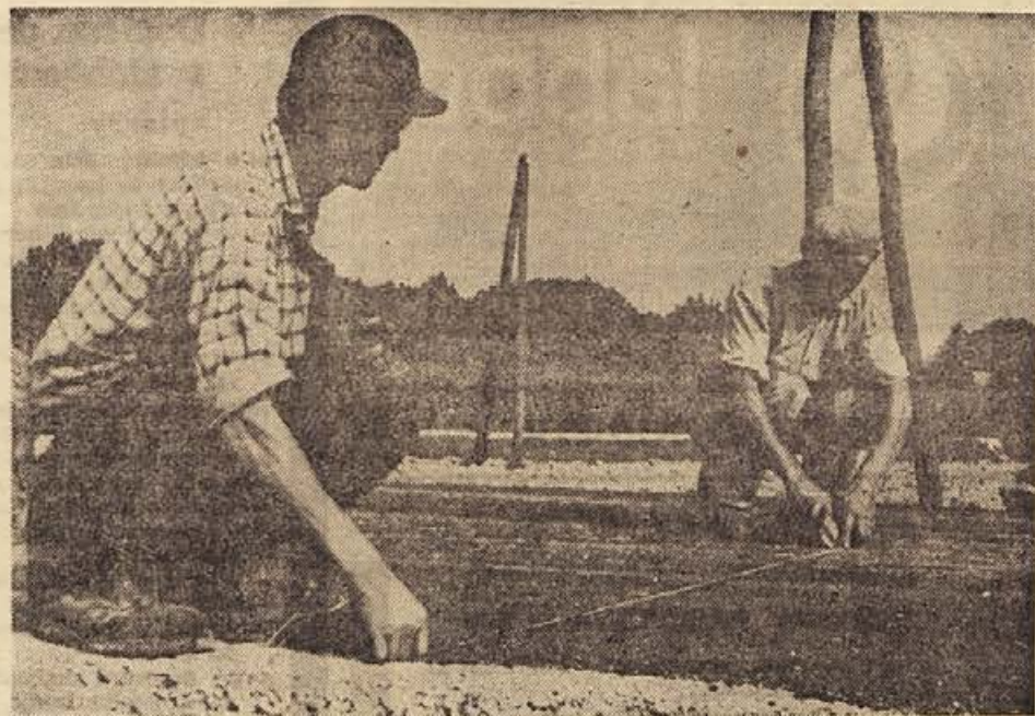
Dobro uro pred otvoritvijo ceste Bizeljsko—Zupelevec sta delavca cestnega podjetja še zadnjikrat premerila širino asfaltiranega cestišča na križišču pri Zupelevcu. Po končanem delu so se delavci zbrali v Stari vasi, kjer so jim ljudje pridelili skromno pogostitev. (Foto: J. Teppey)
