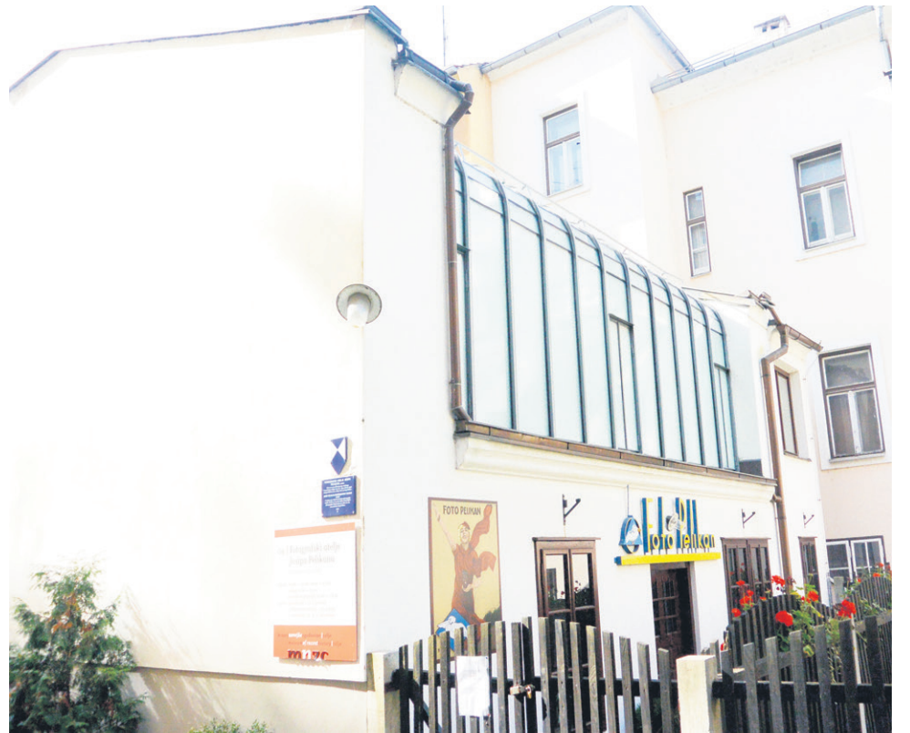
Pogled na skrbno obnovljen Pelikanov atelje v Razlagovi ulici
