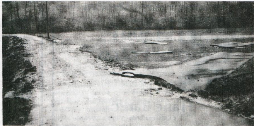
V Trnjava je Radomlja razkopala cesto, asfaltno prevleko pa kot rjuhe razprostrla po bližnjem travniku (Foto: Lipovšek)
