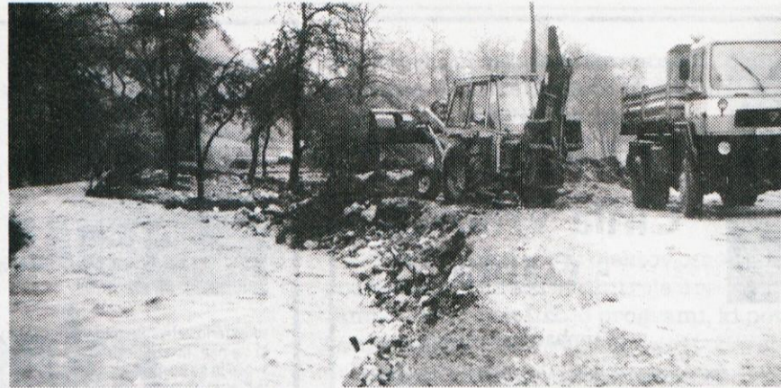
V Zg. Lokah so pohiteli z utrjevanjem brega, ki ga je izpodjedla Radomlja
