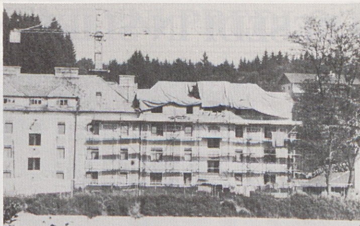
Nadzidava stanovanjskih hiš na Stavbah.
