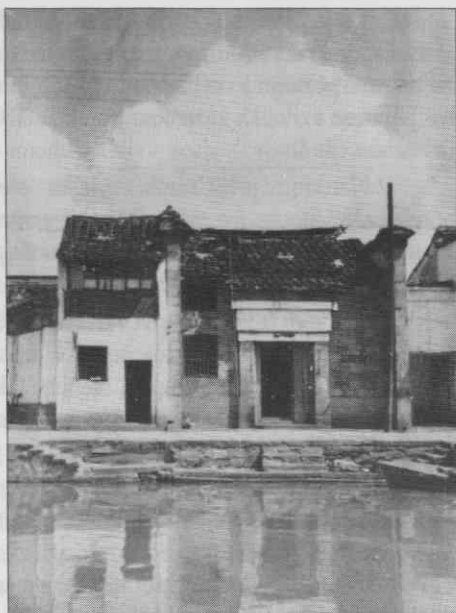
Poslopje barvarskih delavnic »Lize gongsuo« v mestu Suzhou. ♦ Building of the dye-works »Lize gongsuo« in Suzhou. ♦ Bâtiment des ateliers de teinturerie »Lize gongsuo« dans la ville Suzhou.
