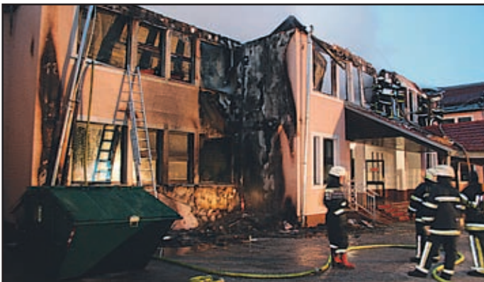
Požar je uničil 11 učilnic in streho.
