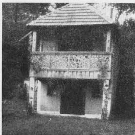
Sl. 6. Primer vinske kleti iz Čentibskih gorci. V pritličju shramba za vino, v nadstropju začasno stanovanje, oziroma prostor za svečane prilike
