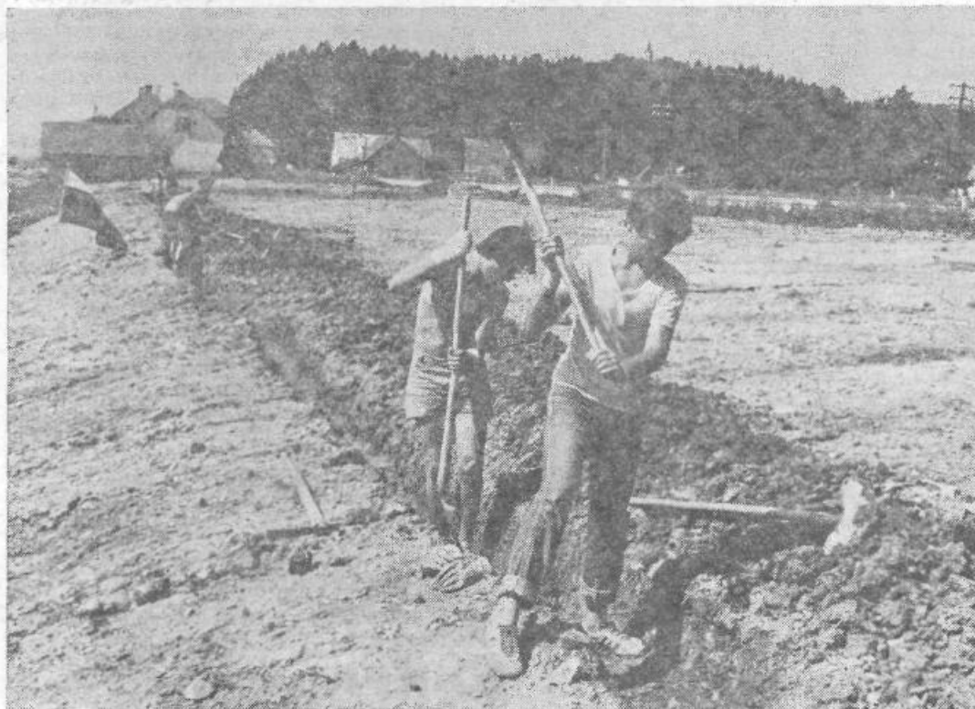
Brigadirji akcije Slovenika 79 pri kopanju jarka za telefonski kabel ob avtocesti (Foto: F. Kmetič)
